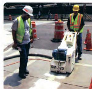
Betonboden erfährt feine Flächenbearbeitung mittels Frästrommel - „kompakt“
